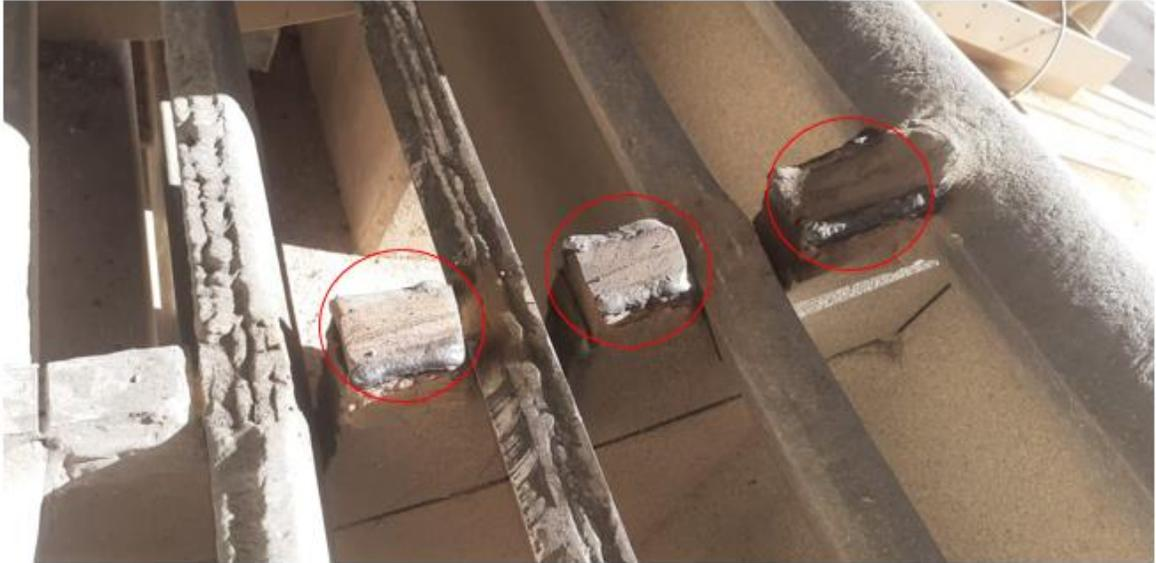
**Fotografía N°10** Recuperación de material base con soldadura con electrodo 9018B3-H4R
