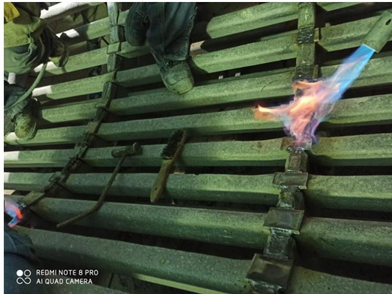
**Fotografía N° 11** Instalación de planchas hardox espesor 6mm
