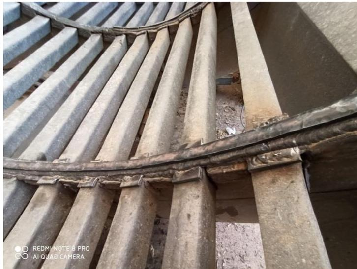
**Fotografía N° 12** Instalación de planchas hardox espesor 20mm y soldadura
